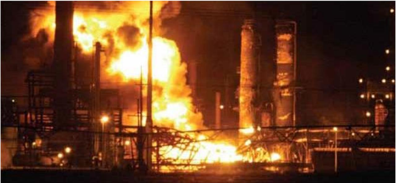
Una **reazione fuggitiva** è la conseguenza della perdita di controllo termico di un sistema reagente con generazione di pressione dovuta alla volatilità della miscela reagente (per sistemi di tipo *vapor*) e/o al raggiungimento della temperatura di innesco di reazioni secondarie di decomposizione molto più esotermiche e con produzione di gas incoercibili (per sistemi di tipo *gassy*).
